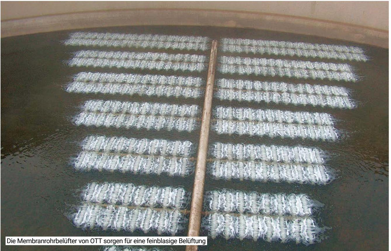
Die Membranrohrbelüfter von OTT sorgen für eine feinblasige Belüftung
