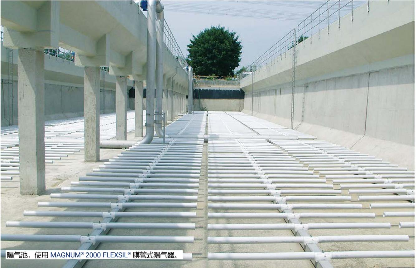
曝气池，使用 MAGNUM® 2000 FLEXSIL® 膜管式曝气器。
