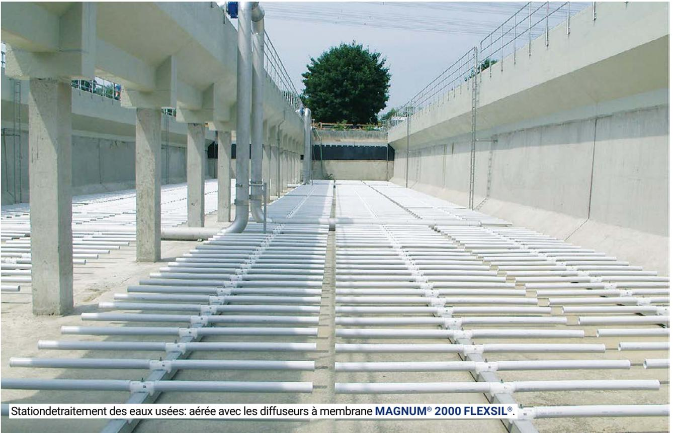
Station de traitement des eaux usées: aérée avec les diffuseurs à membrane **MAGNUM® 2000 FLEXIL®**.
